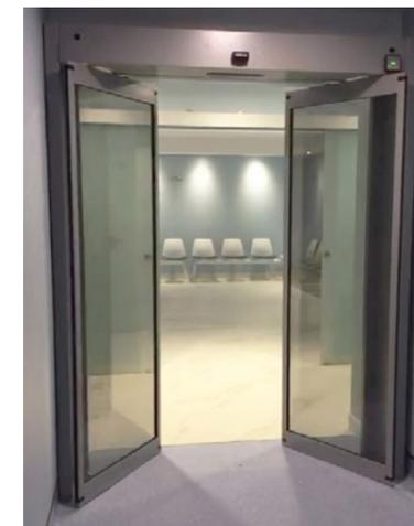
Este tipo de porta é especialmente indicado em situações onde o espaço de instalação é mínimo e se necessita do máximo de passagem livre, como pode ser o caso do corredor de um hospital.
